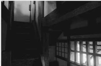
熊本地震前の宇土櫓内部
