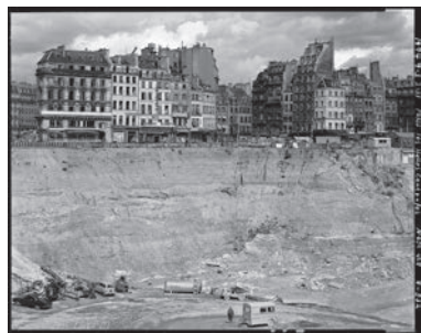
8-00532 1974/9/3 14:51 レアールの工事現場 パリ 1区 フランス
